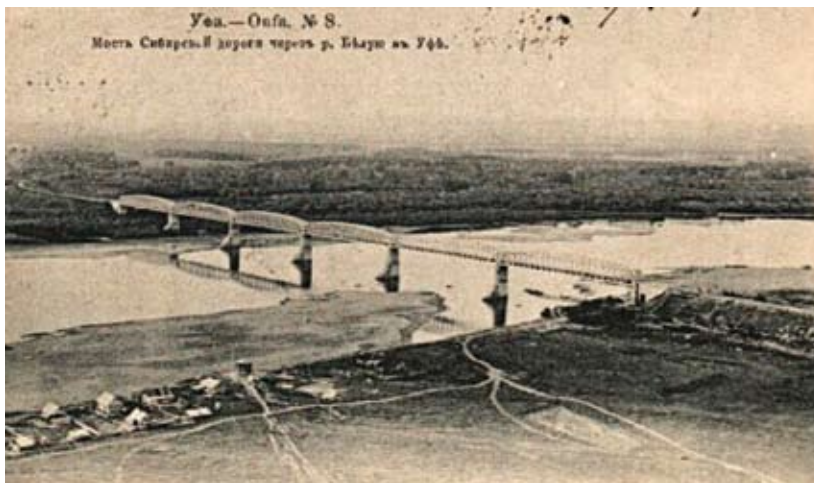
Железнодорожный мост через р. Белая. Открытка. Начало XX в.
