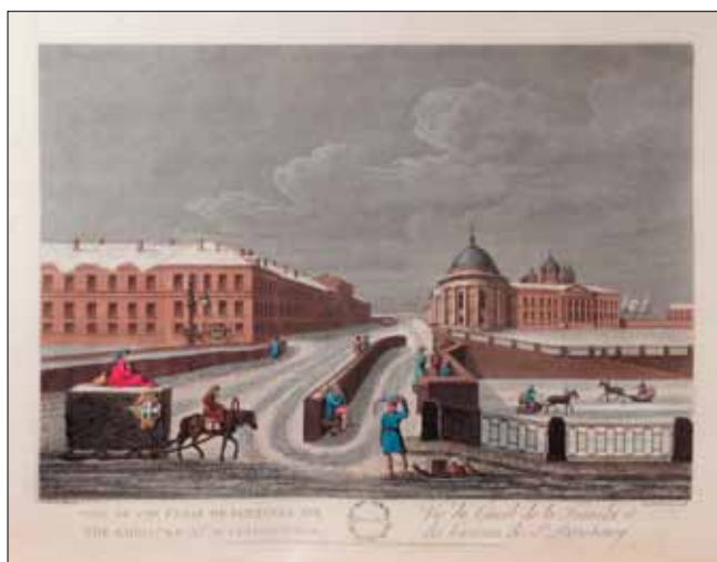
Ноябрь. Вид на казармы на набережной Фонтанки в Санкт-Петербурге.
