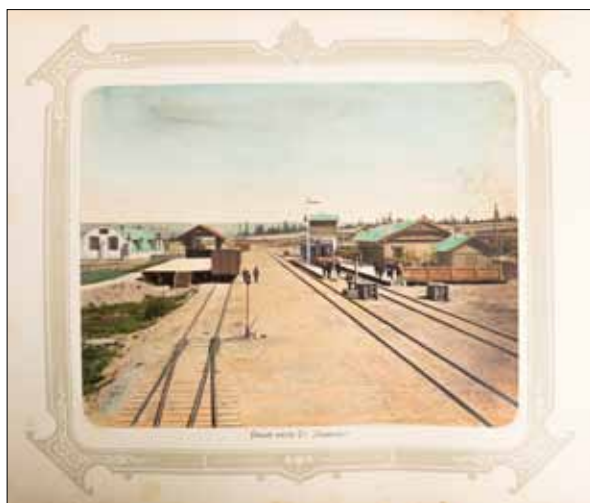
Общий вид Станции Левшино
