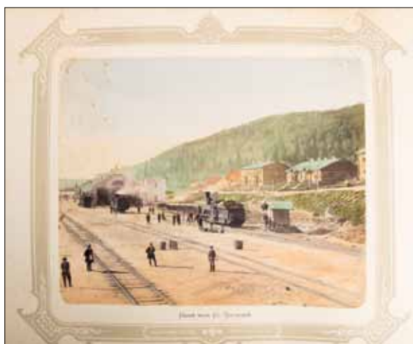
Общий вид Станции Чусовской
